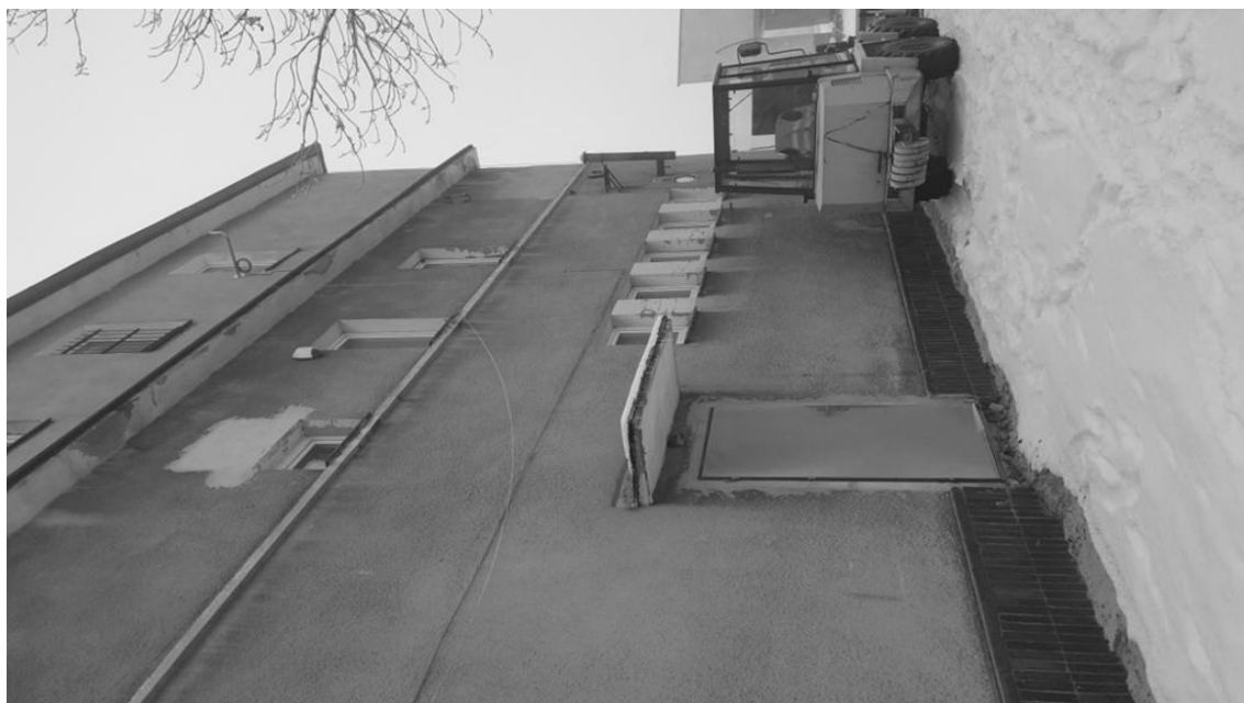
Widok na elewację zachodnią
