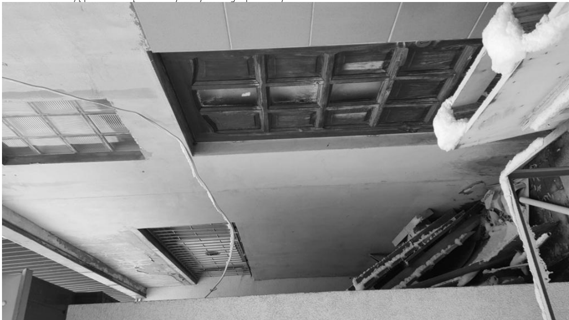
Wnęka między budynkami.
